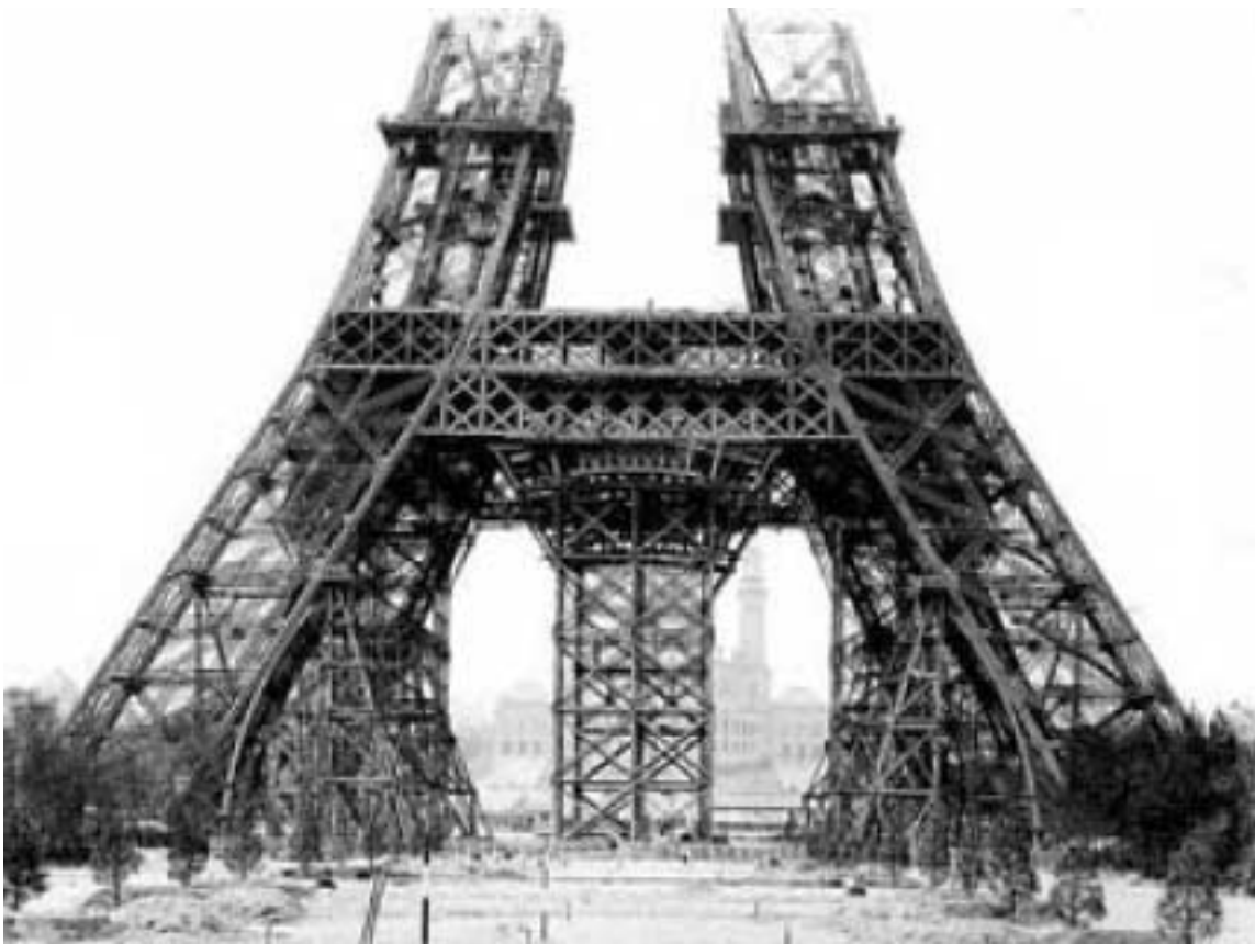
Abbildung 2.1: Was haben die Auftraggeber des Eiffelturms über den fertigen Turm in diesem Moment der Bauphase gewusst?
